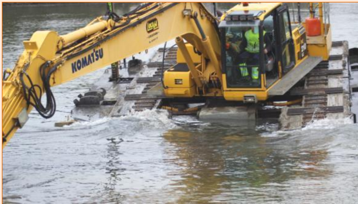
Dragage à la Pelle Mécanique Amphibie - 2019
