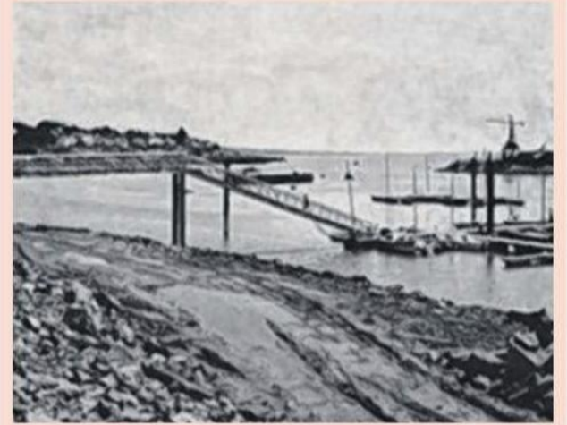
La passerelle d'accès au ponton lors du chantier de construction du port de plaisance en 1970.
